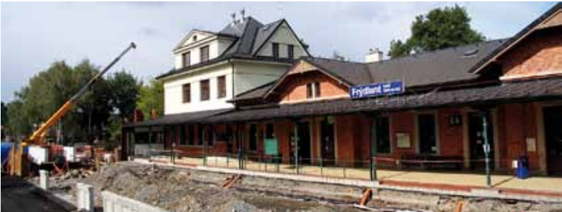
STAVEBNÍ RUCH. Ve Frýdlantu se budují ostrovní nástupiště.
