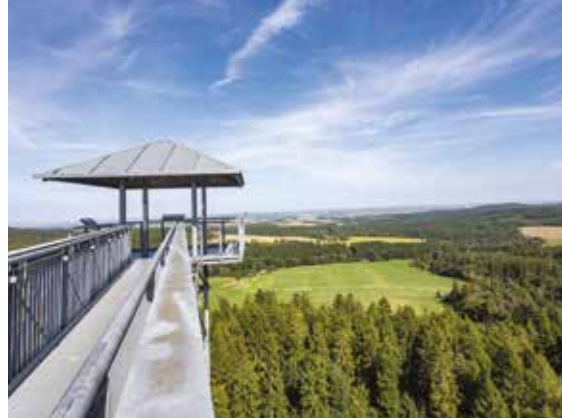
Výhled z lávky propojující obě věže rozhledny Hraniční vrch
