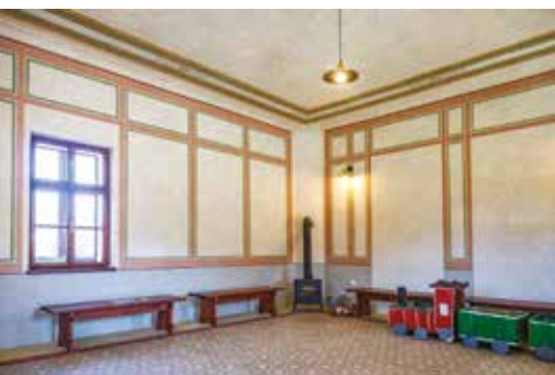
Obnovená výmalba čekárny na nádraží v Bohušově
