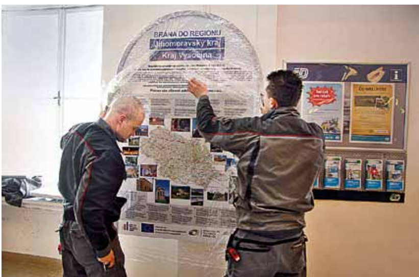
INSTALACE. První infopanel byl umístěn do haly stanice Brno hl. n. FOTO AUTOR
