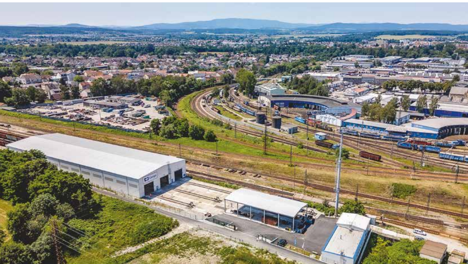
Pohled na část areálu SOKV České Budějovice včetně nové haly na opravy nákladních vozů (vlevo)
