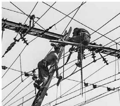
Elektrifikace stejnosměrným proudem 1500 V úseku Chalon-sur-Saône a Lyon-Perrache
