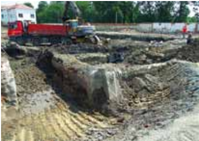
Stavební firma postupně vytěžila téměř 33 tisíc m³ zeminy. FOTO RSM OLMOUC
