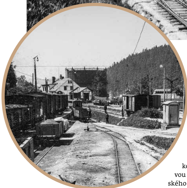
Pohled na překladiště Dolní nádraží kolem roku 1913. Vlevo jsou železniční vozy, ze kterých se bude překládat na menší vozy tramvajové.
