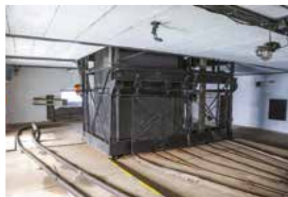
Uvnitř šachetní budovy starší jámy Julie
