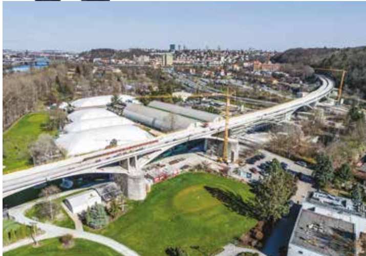
Pevninská část téměř kilometrového Branického mostu
