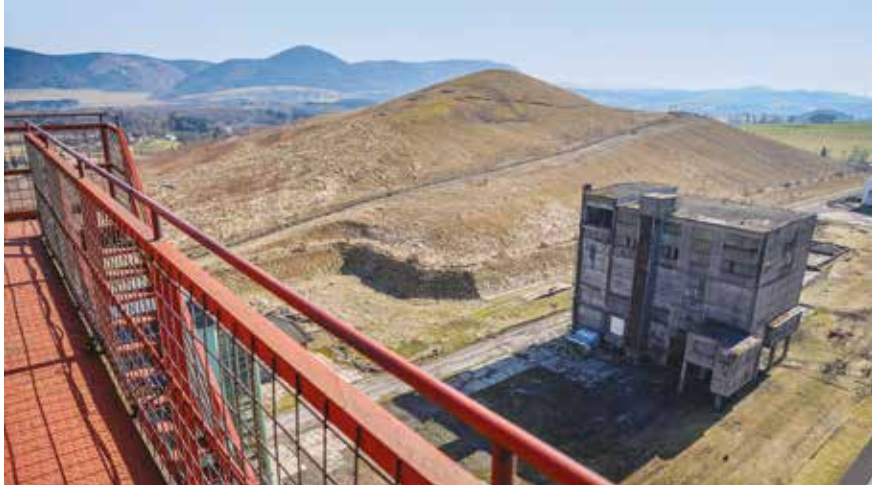
Pohled z těžní věže Jan na téměř 100 metrů vysokou haldu Dolu Jan Šverma
