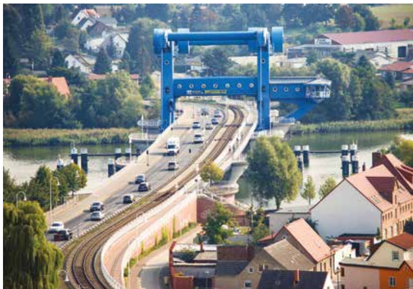
Cestu na ostrov Usedom ve Wolgastu umožňuje kombinovaný zvedací most pro silniční a železniční dopravu.
