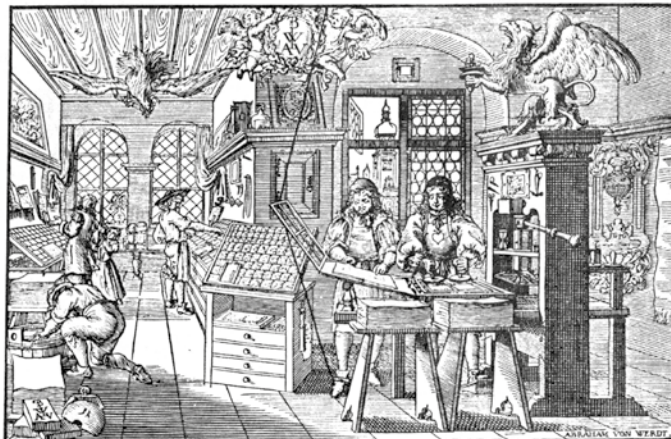
Sazárna a tiskárna 17. a 18. století. Dobře jsou vidět ruční sazeči u kas s písmem a dva tiskaři u lisu. Nad nimi je pták Noh s tampóny – cechovní znak knihtiskařů.
